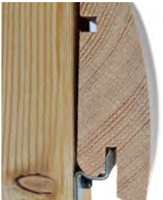
inserire il listello romboidale con la fresatura
