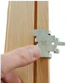
posizionare il clip ed inserirlo con una leggera pressione
