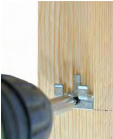
fissare il clip iniziale nella posizione segnata
